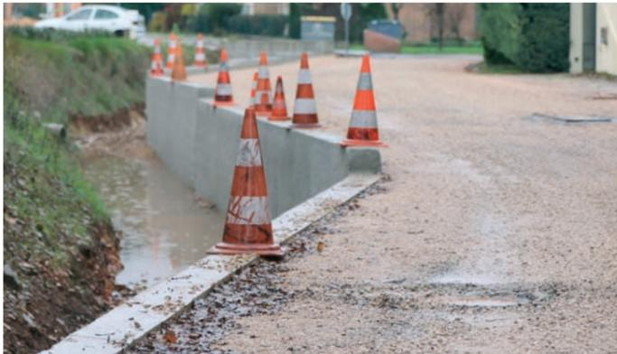
Au quartier Pichabert 1 à proximité de la casse, proche de la RDN7, des travaux ont été effectués sur le pluvial bouché par les intempéries et partiellement effondré.
