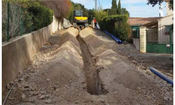
Avec un diamètre doublé, la canalisation d'eau assure désormais un débit en eau potable de 60 m<sup>3</sup>/h.
